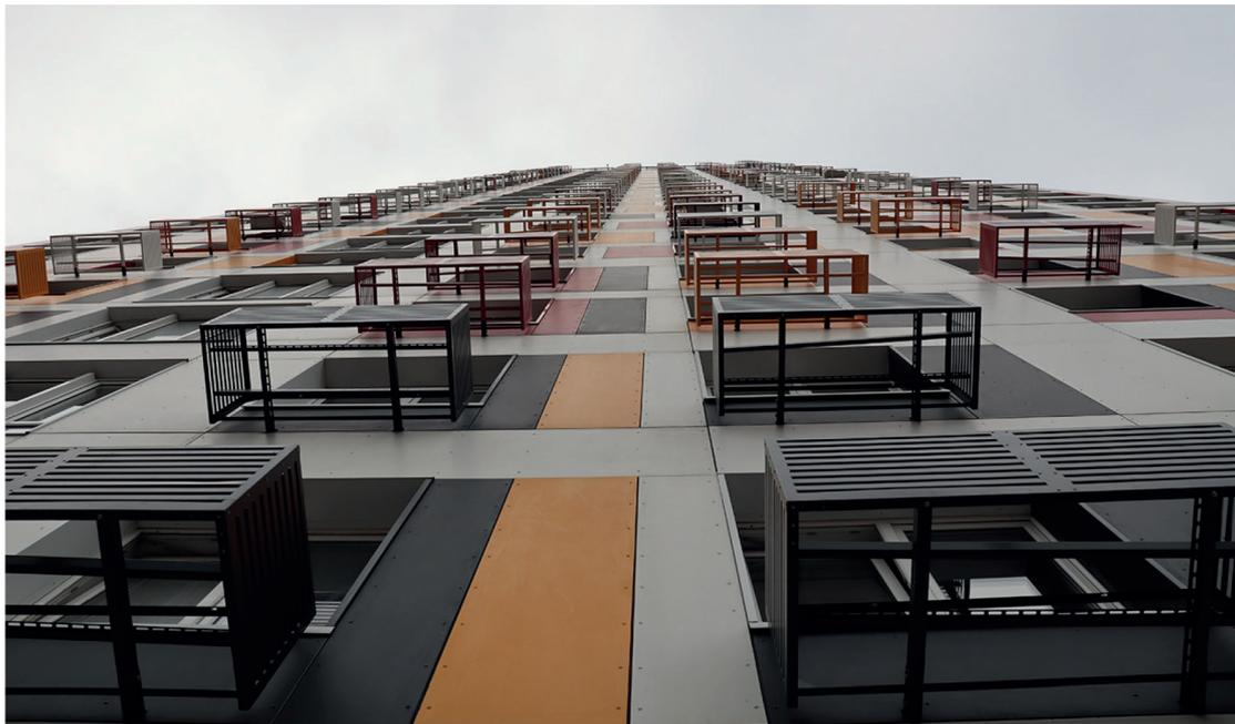
**Рис. 3.** Корзины для внешних блоков кондиционеров под окнами на фасадах высотного здания (Жилой комплекс “Спутник”) (фото автора)
