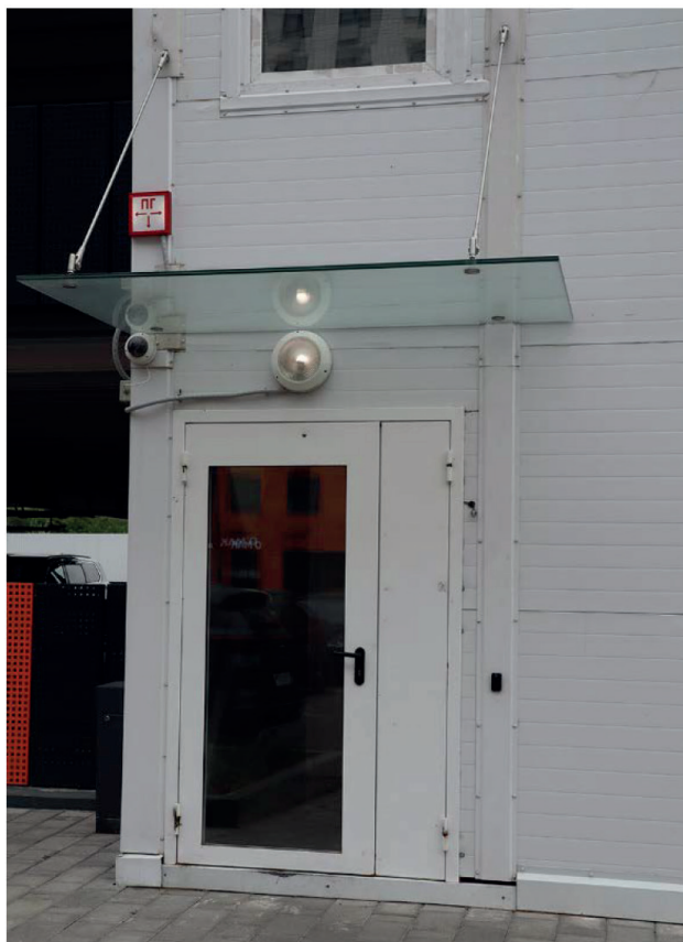
Рис. 5. Вход в паркинг с прозрачным козырьком (фото авторов)
