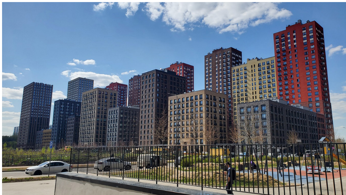
Рис. 1. Современные высотные здания (фото Стариковой А.С.)
