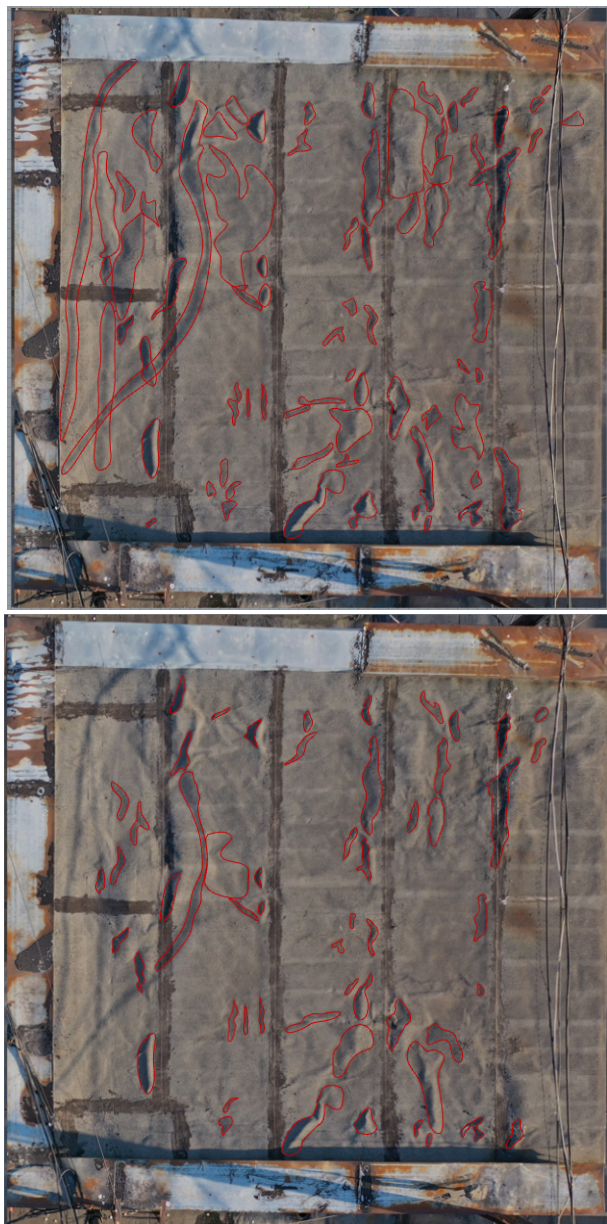
Рис. 1. Дефект «Вздутие», определенный разными экспертами
