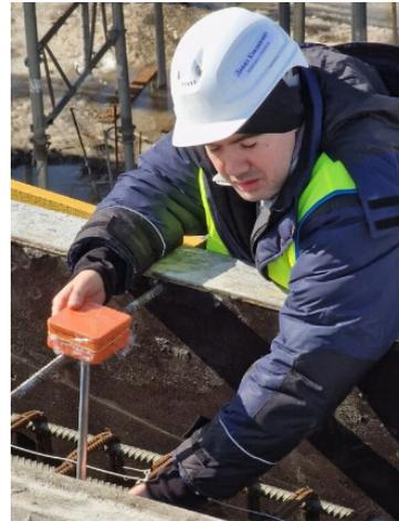
Рис. 6. Установка температурных датчиков
